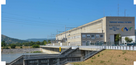
Centrale hydroélectrique de Bourg-lès-Valence - SM SCoT Rovaltain
